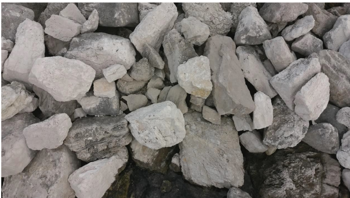
Εικόνα 5: Λεπτομερής άποψη του βασικού λιμενοβραχίονα της περιοχής (πηγή: η από 01/2024 Τεχνικής Έκθεσης του ΕΛ.ΚΕ.Θ.Ε.)
